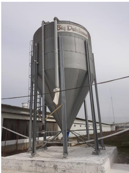
Fig.10- Siloz cu capacitatea de 27 to
