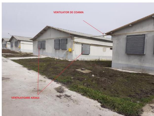
Fig.16 – Amplasare sistem de ventilatie halele H1÷H13
