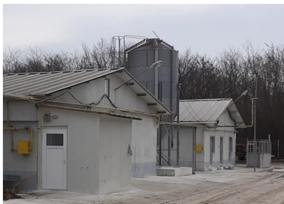
Fig.28 - Hala 11 cu silozul aferent (stanga) si Pavilion administrativ nr. 1 (dreapta)
