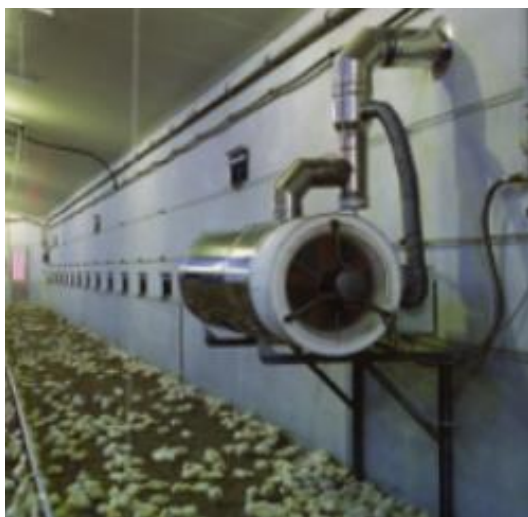
Fig.15- Sistem de incalzire cu generatoare tip EMARF( halele H14÷H16)
