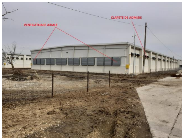
Fig.17 – Amplasare sisteme de ventilatie halele H14÷H16
