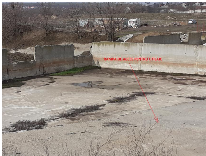
Fig.30 – Bazin pentru precolectare levigat
