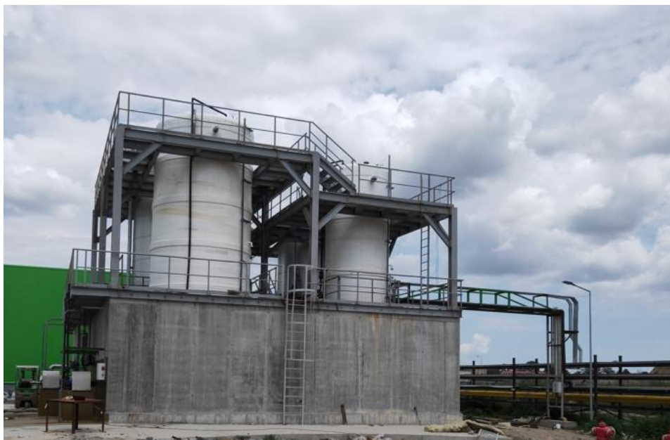
Foto: Vedere laterala a Rezervoarelor de acide-caustice
