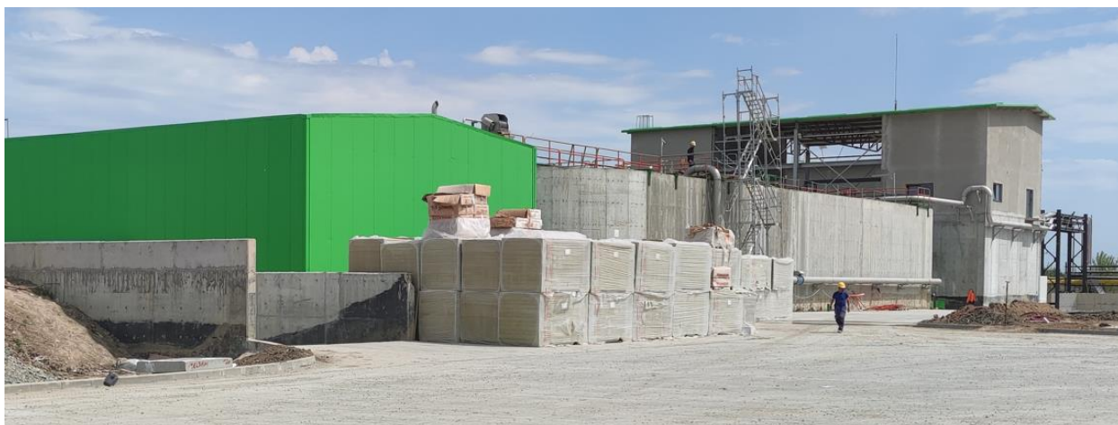
Foto: Statia de epurare din incinta
