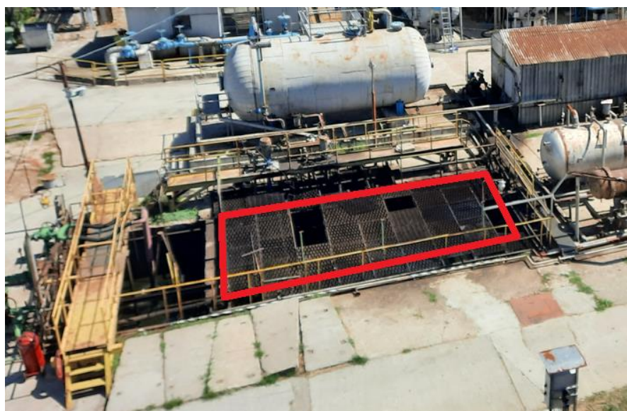
Foto 3 – Aria de montaj a noii cuve separator
