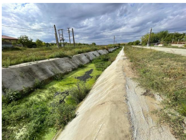
Degradare majora deversor colmatat
