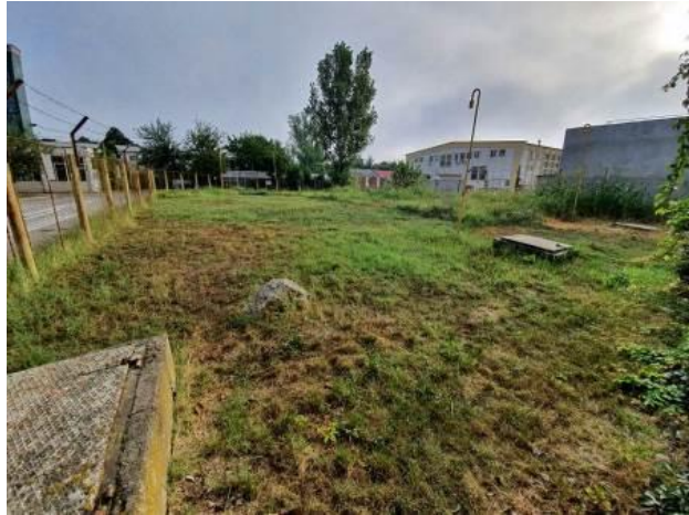
Camine de vizitare rezervoare subterane si guri de aerisire
