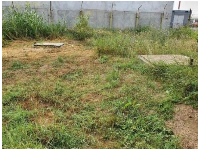
Camine de vizitare rezervoare subterane
