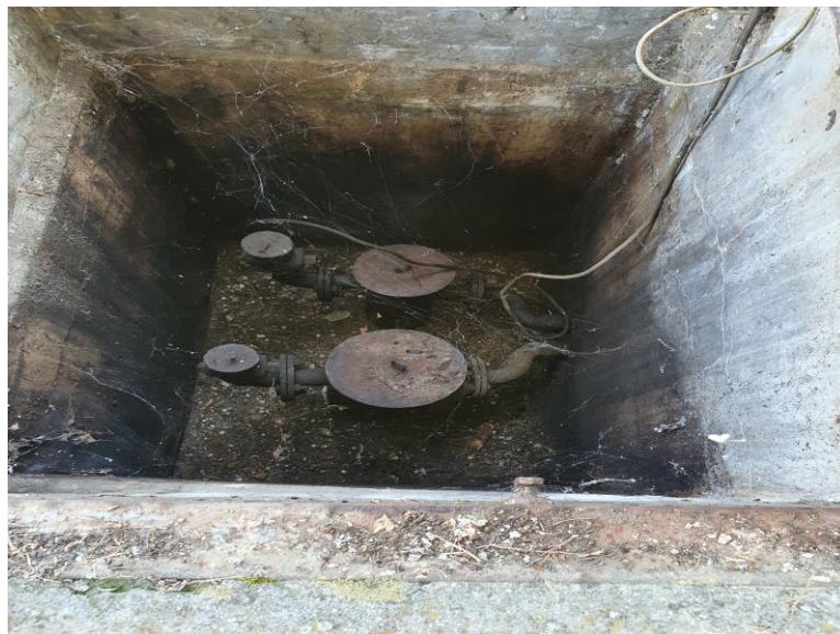
Camion de vizitare rezervor subteran
