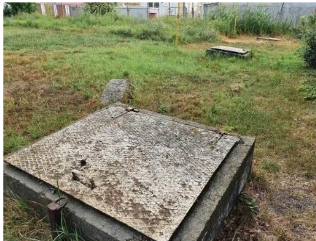
Camine de vizitare rezervoare subterane
