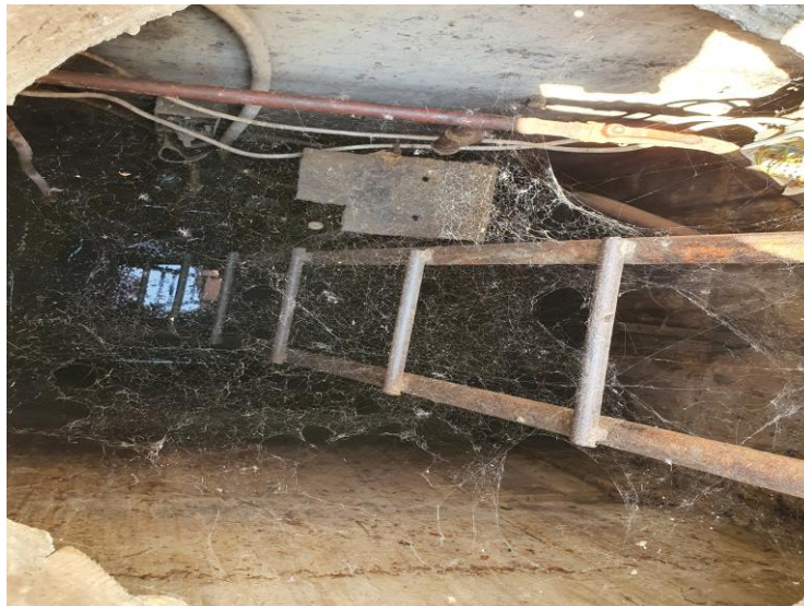
Camin de vizitare rezervor subteran si scara de acces
