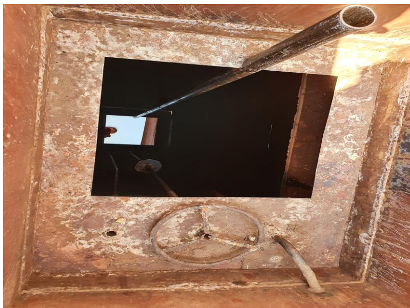
Gura de vizitare rezervor subteran si racord masurare
