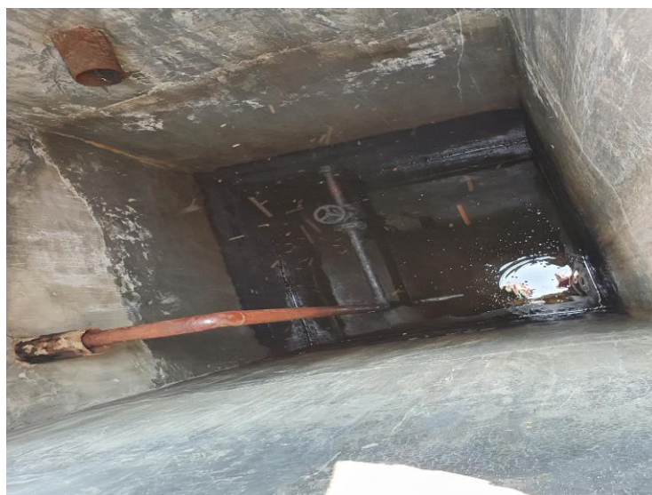
Camion de vizitare rezervor subteran
