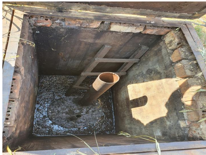
Camine de vizitare rezervor subteran si racord masurare
