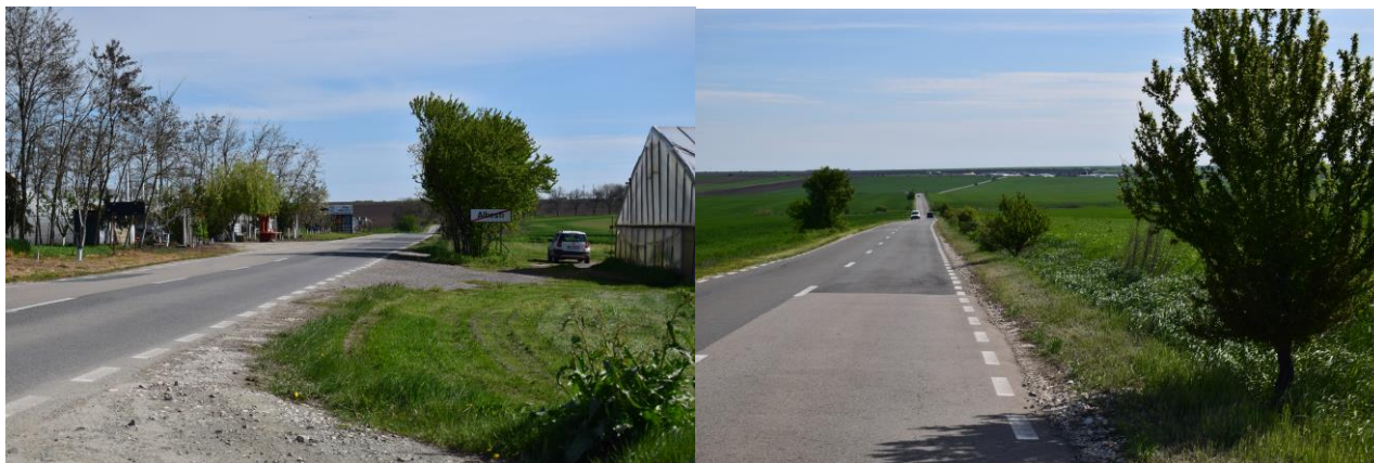
Aspecte ale DJ391 – de-alungul căruia va fi îngropată conducta de aducțiune către stația de epurare a municipiului Mangalia
