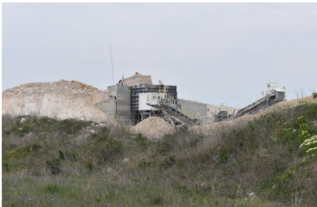
Fig. nr. 2 Instalatia de concasare din cariera Tașaul Corbu (foto realizata in data de 07.05.2022)
