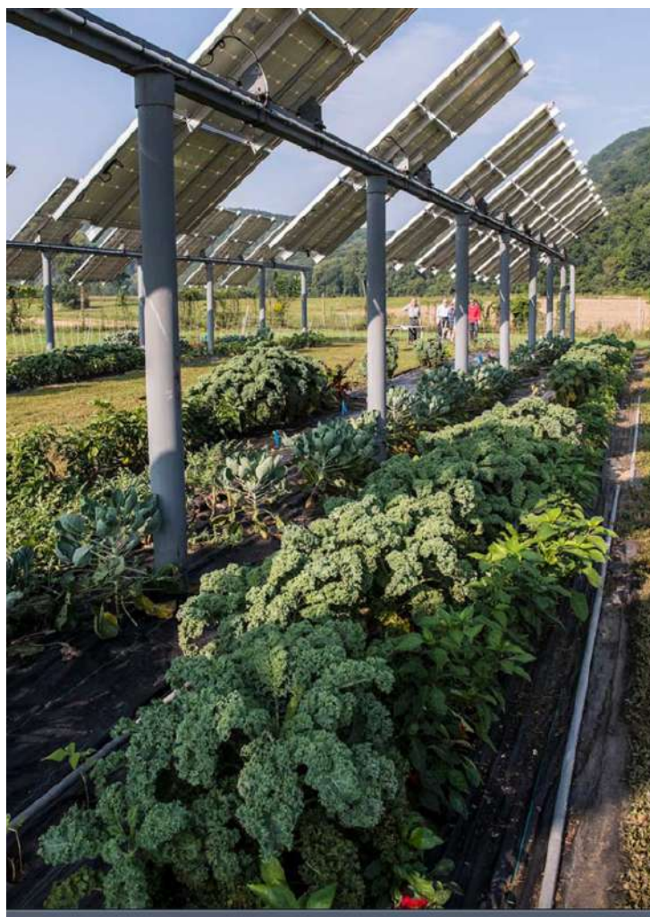
Figura nr. 7-8 Conceptul Agrivoltaics implementat la un proiect fotovoltaic in SUA (sursa nrel.gov)
