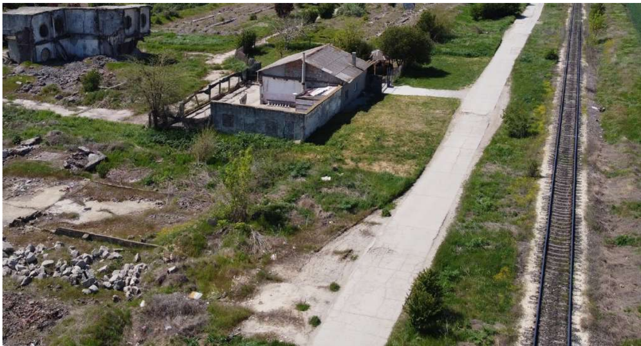
Figura nr. 7-5 Receptorul R7- proprietate privata de locuit in regim temporar, aflata in vecinatatea limitei proiectului PV Nazarcea
