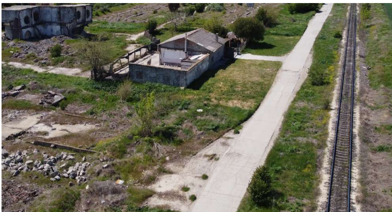
Figura nr. 7-23 Prima casa -Casa de locuit in regim temporar-in zona vestica a limitei proiectului langa calea ferata
