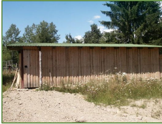
Foto nr. 11 Capcana centrală vedere laterală Foto: IM
